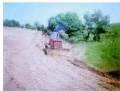
II. Gépesített szakmunka
