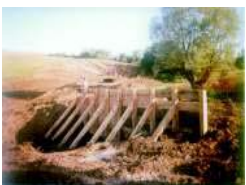
V. A megépített árapasztó bukó
